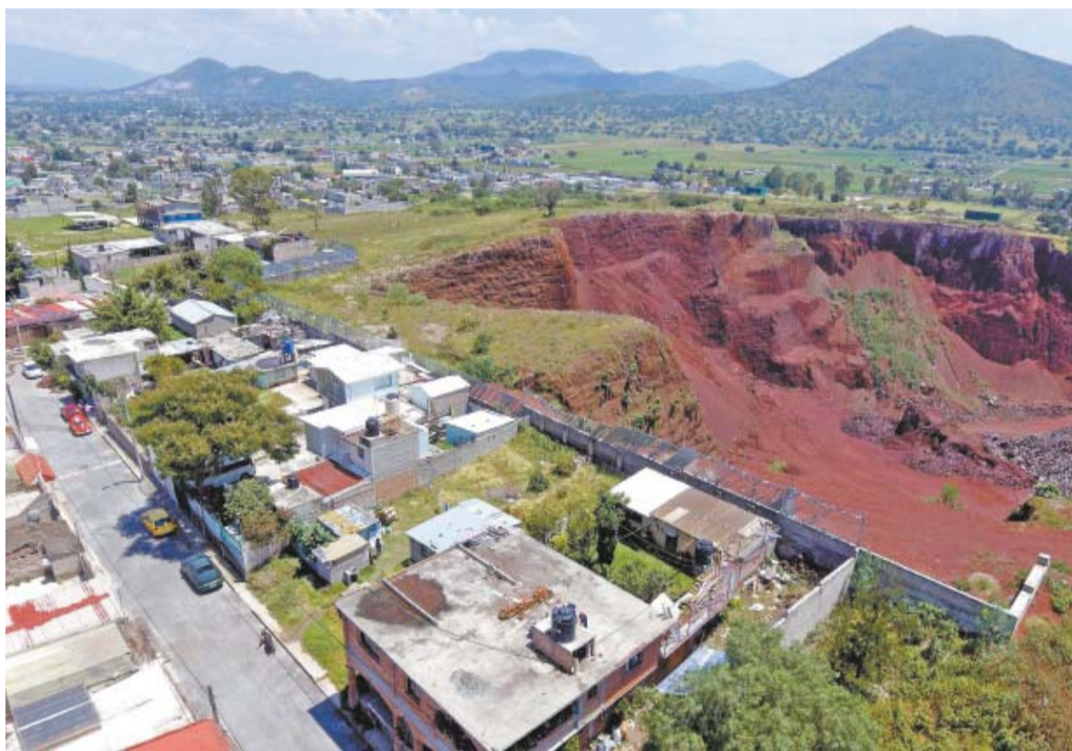
En Tezoyuca, varias familias viven al lado de un precipicio causado por una mina para el aeropuerto de Texcoco, por lo que sufren enfermedades respiratorias debido al polvo fino que se levanta en el lugar.
